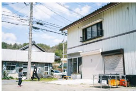
《naturadistill 川内村蒸溜所》
