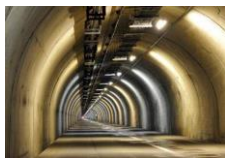
関越トンネル 避難坑
