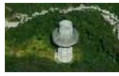
関越トンネル 谷川立坑
