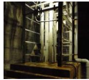
関越トンネル 立坑階段
