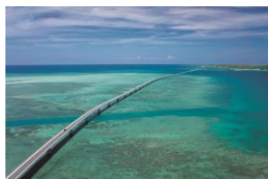
伊良部大橋(全長3,540m / 宮古島～伊良部島)
